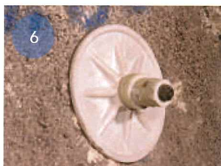
Finalne naprężenie kotwy KGC KW
